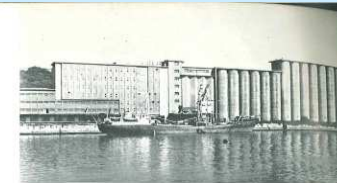
Silos et Semoulerie Skalli.
