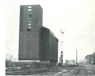
Le silo de la Société Lévy en construction à Dieppedalle.
