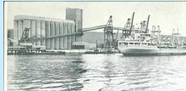
Les silos du Magasin de Rouen Maritime.
