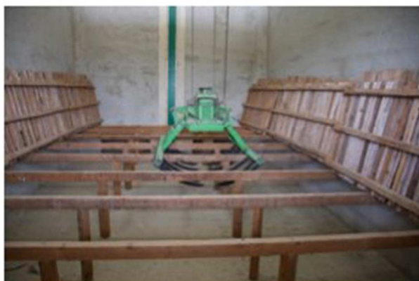
Caillebotis (8) avec tunnel de ventilation
