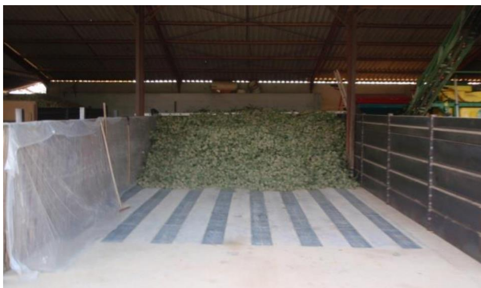
Figure 13 : Exemple de séchoir à caniveaux 16
