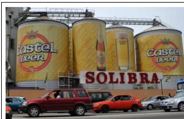
Figure 6 Brasserie SOLIBRA à Yopougon
