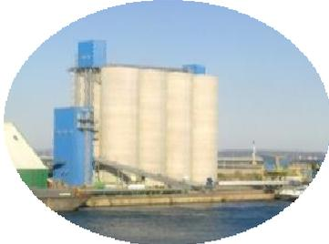
**Novembre 2009, construction d'un nouveau silo** Structure béton avec vidange gravitaire
