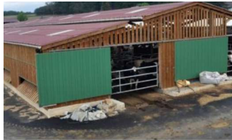
Le premier bâtiment Stabeco construit en France, au Gasc Landat-Maressacqier (Dordogne), est composé d'un bi-pente et d'un mono-pente abritant trois rangées de logettes. À noter les volets pour régler l'entrée de l'air. © DR
